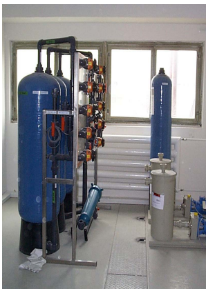
Installation de station d'eau déminéralisée
